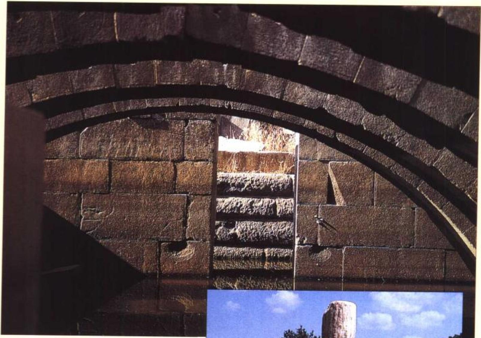
■ (上图)上升的水面使神庙的地下室有部分浸在水里。中世纪的一场地震把神庙的地上部分夷为平地，但地下室残留下来，渐渐地里面塞满了洪水带来的泥沙。墙拱支撑着神庙雕像的巨大重量。
