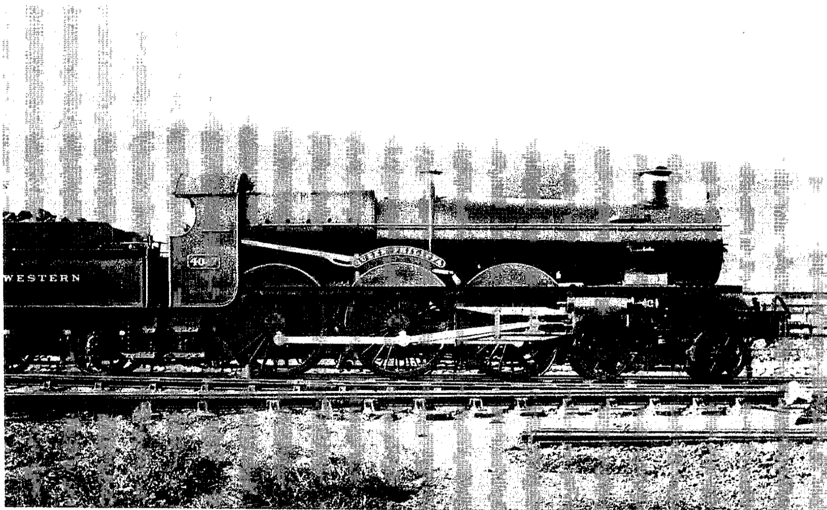
图 32.2 大西铁路公司的“菲莉帕女王号”(Queen Philippa)四汽缸 4-6-0 型机车,属于丘奇沃德的“星”级机车,是“城堡”和“国王”级的先驱。
