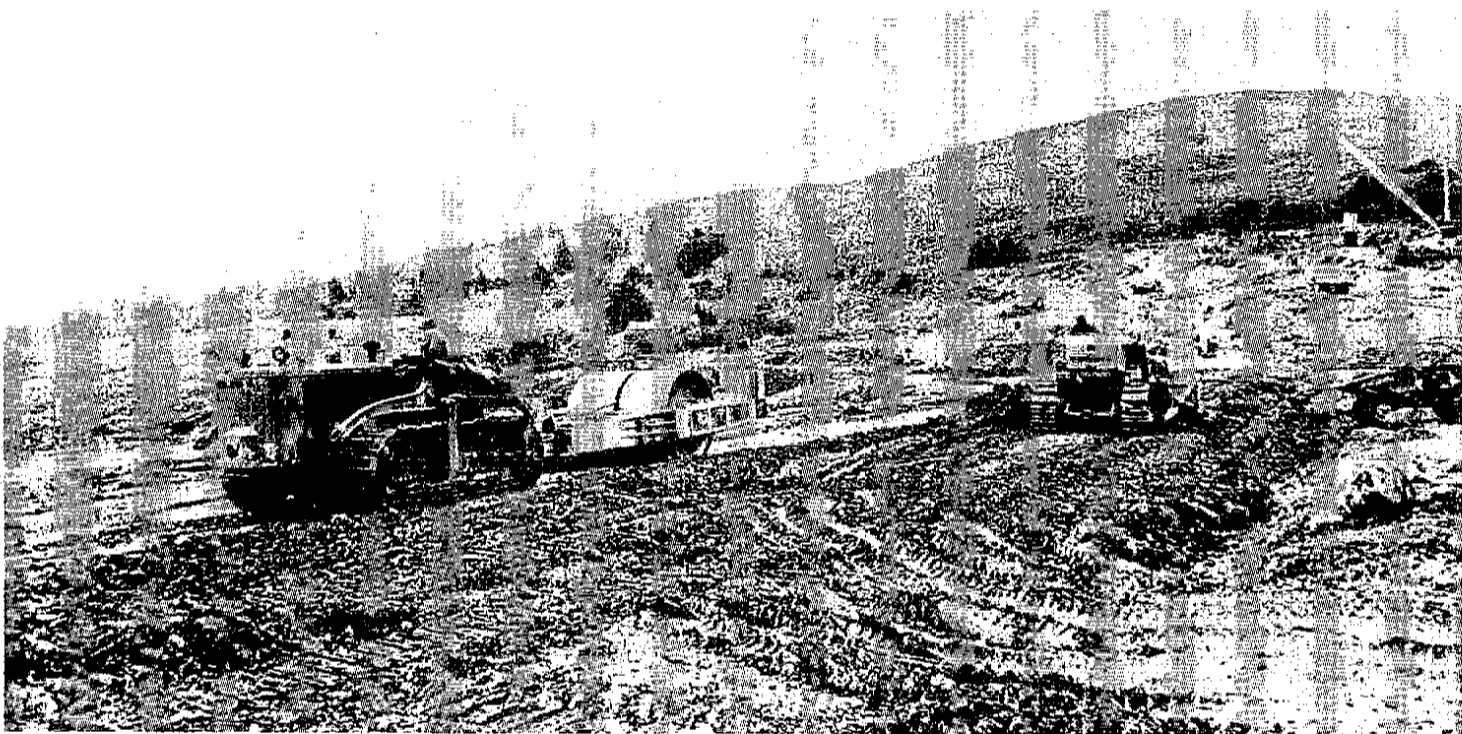
图 55.1 坚实的由粘土碾压而成的心墙。
