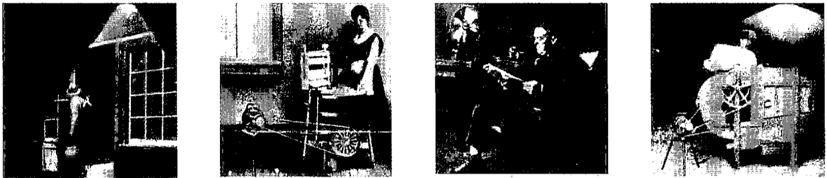
图 40.4 由一台单缸煤油发动机驱动的 1918 年便携式发电装置及其用途示例。
