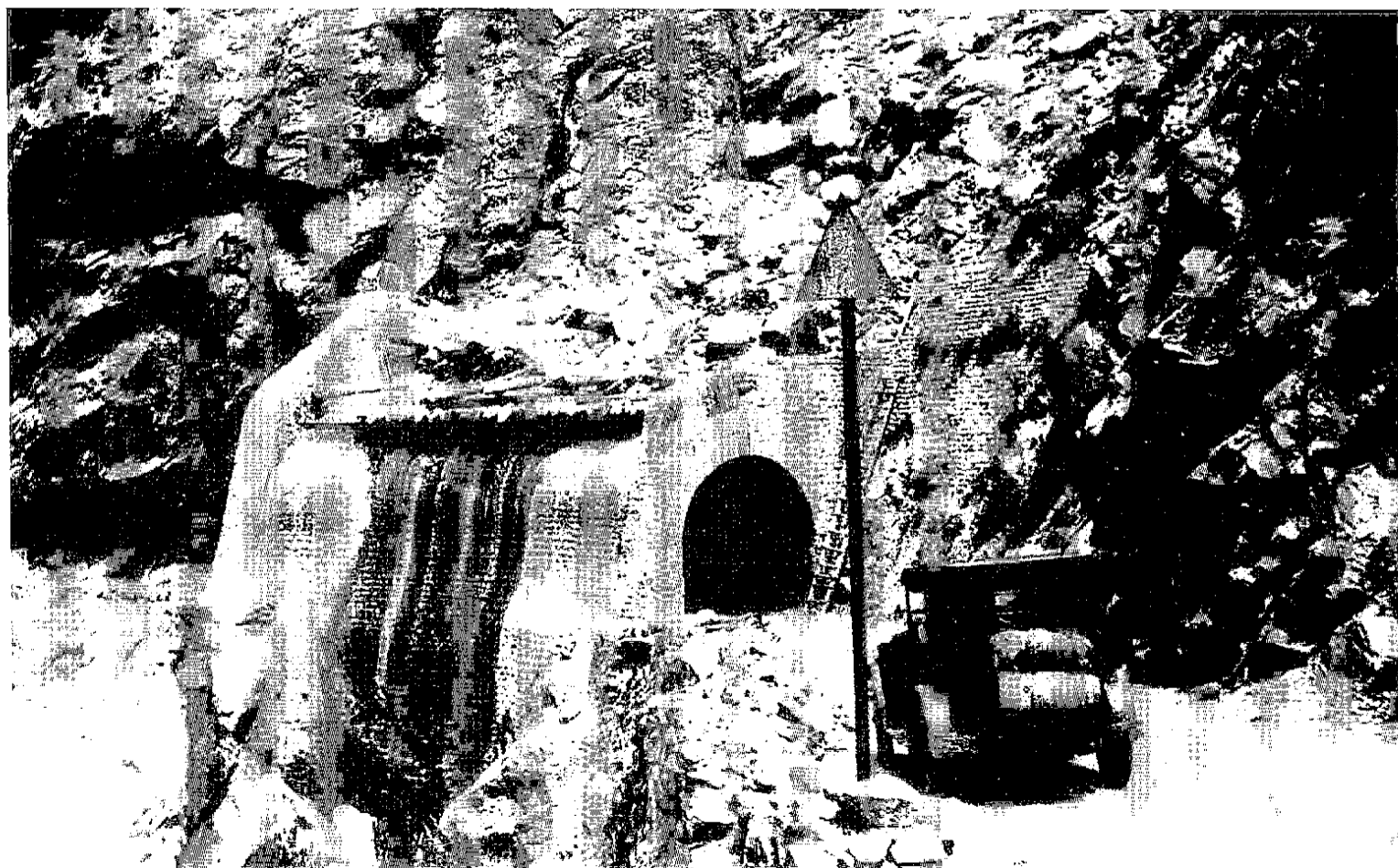
图 36.1(b) 巴里赫大车道上的重型建筑物:一个防护小规模雪崩的隧道。
