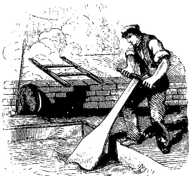
图 179 粘土的“搅拌”。用一把带有横把手的长柄平铲,将粘土和水搅拌混合。这种平铲一般用栲木制成。背景中有一个筛网,液体就通过它流入蒸发槽中。
