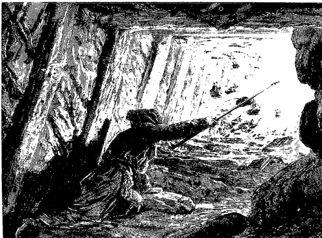
图 51 裹在湿麻袋中的瓦斯检查员,他正在点燃瓦斯以把工作区清理干净。
