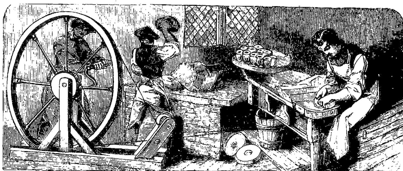
图 180 粘土的揉搓是用一块粘土拍打另一块,以排除其中存在的所有气泡。由人工操纵的一个大转轮正在带动一个陶车转动。
