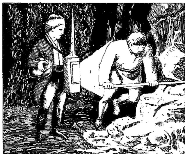
图55 克兰尼的鼓风灯,第二种形式,1816年。这种灯要系在男孩的皮带上,他也负责操作手风箱。
