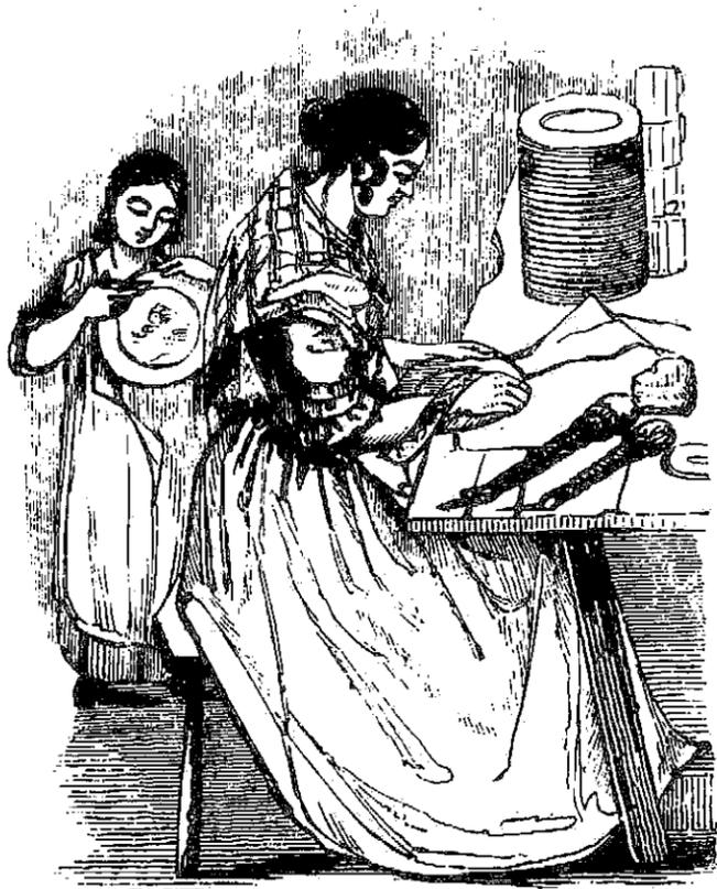
图 194 用滚子将纸版上的图案拓印在器皿上。然后将纸版放入冰水中清洗。将翻印上图案的器皿加热,除去油分,最后就可上釉。
