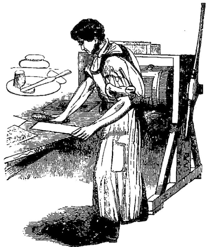
图 193 在印花法中,先将图案花样雕刻在铜版上。然后对其加热并涂上一层金属氧化物与油料的混合物。刮去多余部分,用专用的纸张浸上皂液润湿后,将图案印下。
