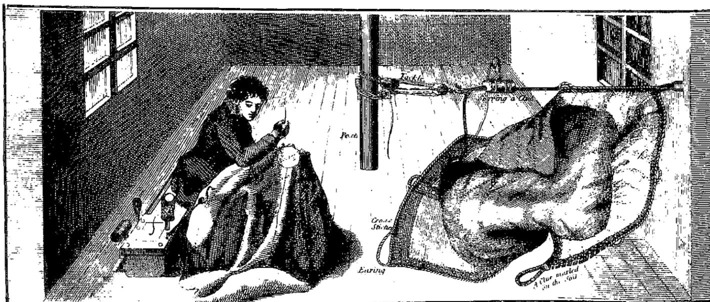
图 323 制帆。图中所示的工具包括可通过一个滑车与之一起拉紧缝到帆上的边绳的帆钩, 缝纫橡胶和木槌, 缝帆时顶针用的掌盘和针。
