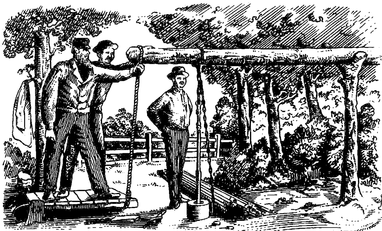
图40 用冲击式凿岩法“蹬出”一口井来。
