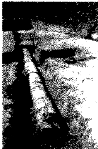
2.二号殿基址(F2)西侧排水管道(北-南)
