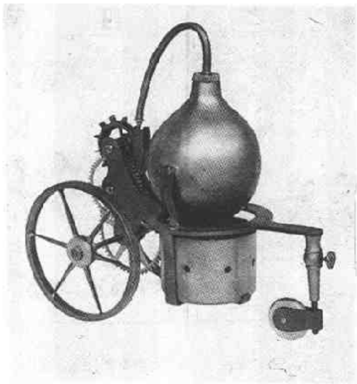
图 16-6 南怀仁蒸汽汽车复原模型(藏米兰国家科技博物馆, 引自李约瑟文,第 427 页注①)
