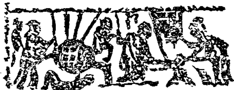
图 11-1 汉冶铁画像石,左边一人正在操纵橐鼓风
